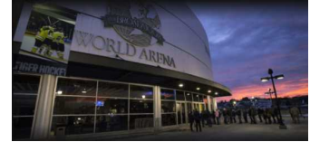
出典：Broadmoor World Arena 公式HPより
