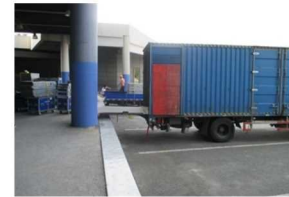
メルセデスベンツ・アリーナ(上海) トラックの段差に合わせた搬入口 出典：(株)日本政策投資銀行提供
