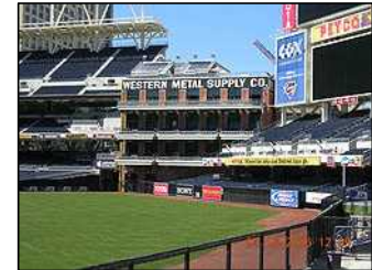
出典: the City of San Diegoウェブサイト "Western Metal Supply Co. Building" より
