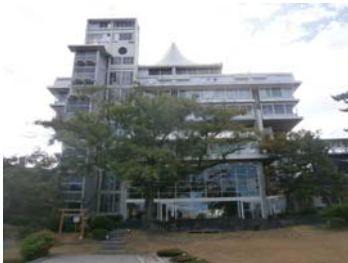
創建当時と同じ外観
